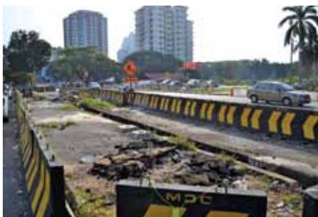
KEADAAN Jalan Sungai Dua yang dinaiktaraf.
