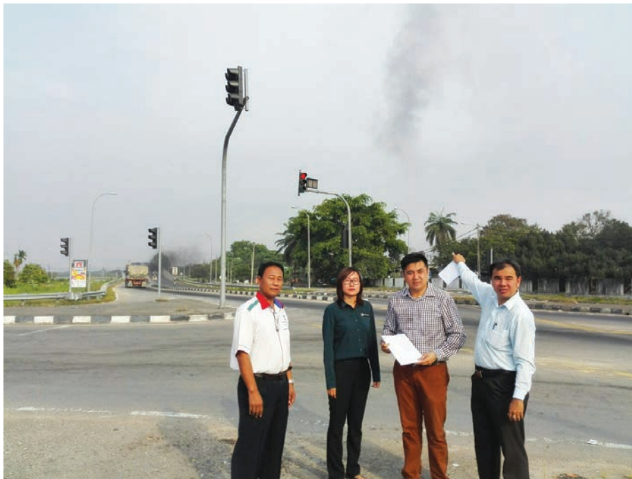
爪夷区州议员孙意志（右起）与威省市议员方美铼及王育璇前往巡视由马矿业金务大机构联营公司(MMC Gamuda)在全威省兴建的18座高架公路，在建竣2年后依然未把7处交通灯和11处高架公路的路灯移交给威省市政局管理。
