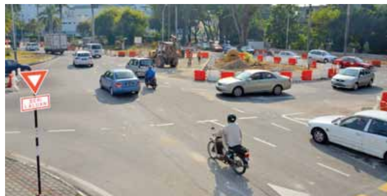
LOKASI kerja-kerja penaiktarafan dijalankan.
