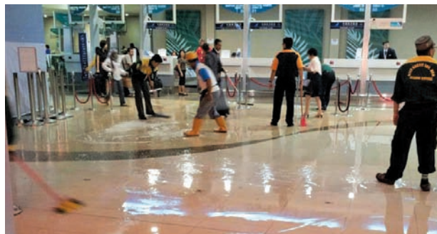
KEBOCORAN pada siling LTAPP pada Oktober lalu.
